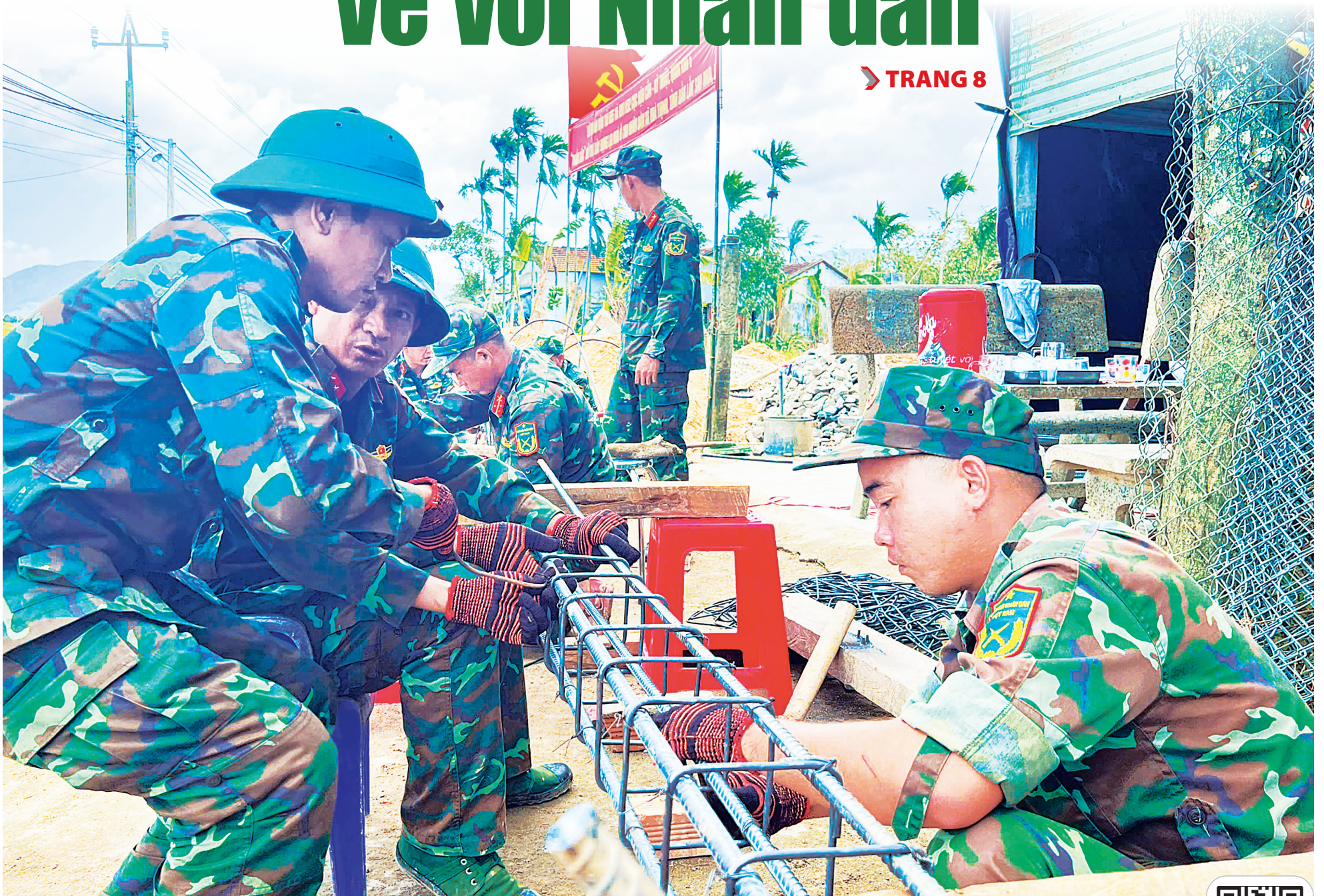
Các chiến sĩ cắt thép xây dựng theo bản vẽ, bảo đảm từng thanh thép đạt tiêu chuẩn kỹ thuật trước khi lắp dựng để xây nhà kiên cố cho người dân Đắk Lắk. Ảnh: Ngọc Dung
