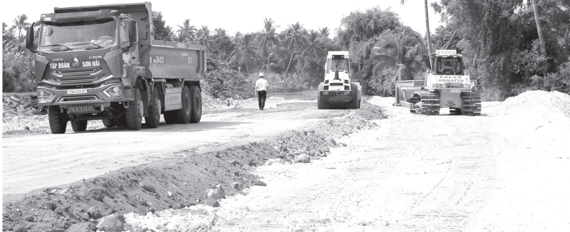
Nhà thầu tranh thủ thời tiết lúc nắng ráo, thi công nền đường đoạn qua phường Bình Kiến. Ảnh: N. Thanh
