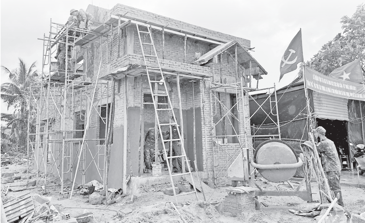
Một căn nhà chuẩn bị hoàn thành ở xã Hòa Thịnh. Ảnh: N. Thanh
