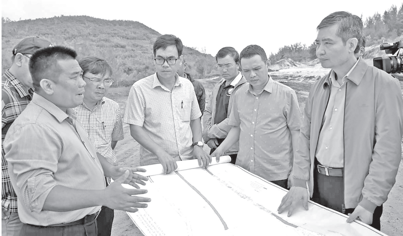
Chủ tịch UBND tỉnh Tạ Anh Tuấn kiểm tra thực tế tiến độ thi công Dự án Tuyến đường bộ ven biển. Ảnh: T. Hương
