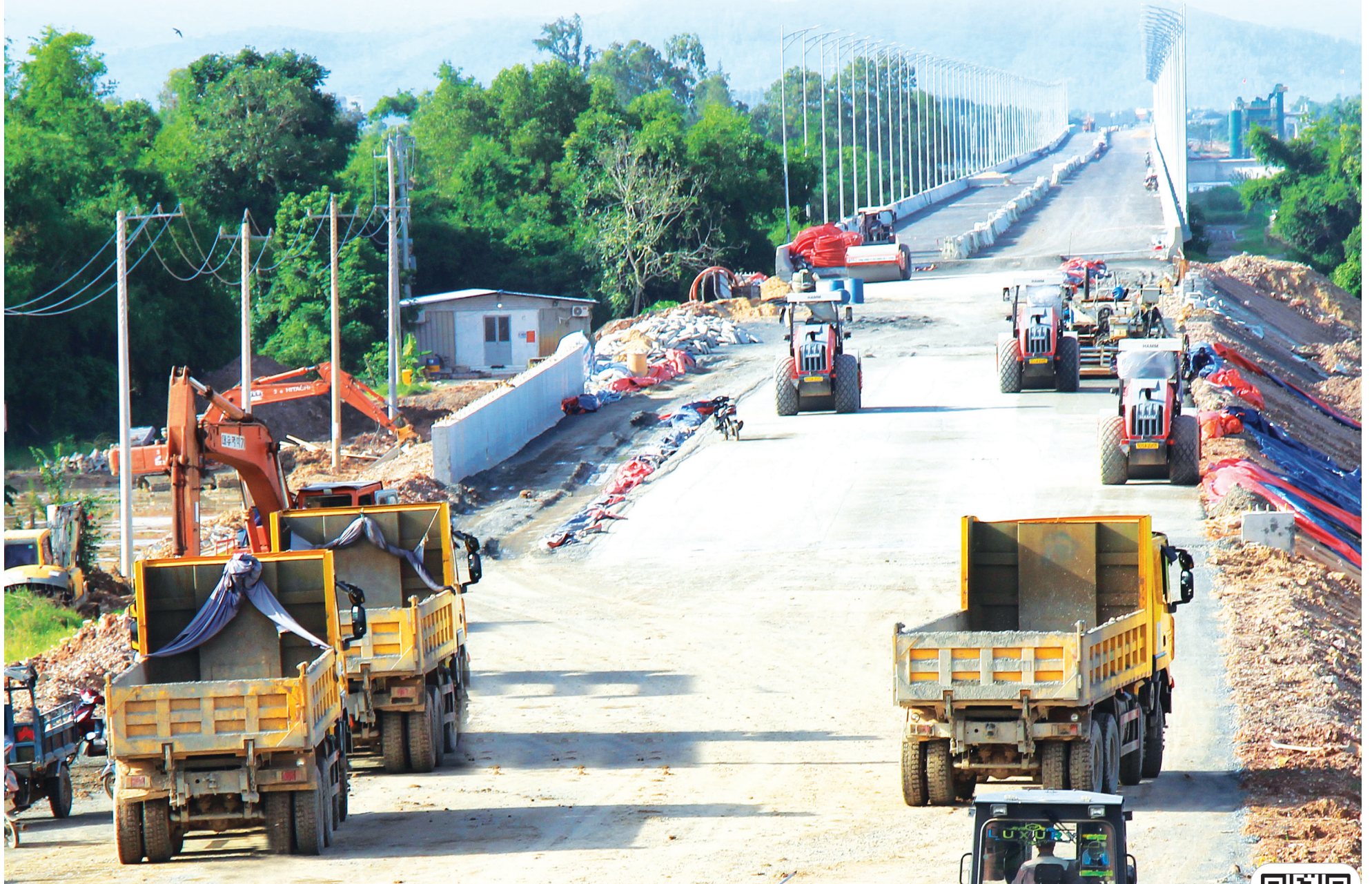
Nhà thầu tập trung thi công để bù tiến độ trên dự án thành phần Chí Thạnh - Vân Phong. Ảnh: Như Thanh
