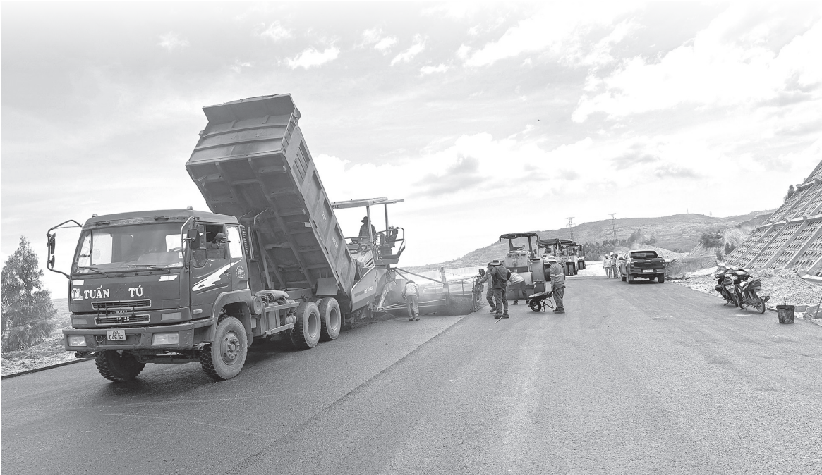
Nhà thầu thảm nhựa mặt đường tại dự án thành phần Quy Nhơn - Chí Thạnh. Ảnh: N. Thanh
