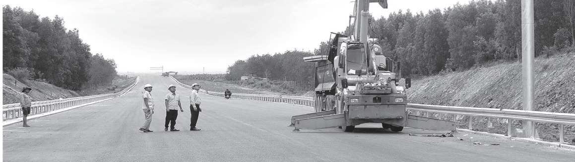
Thi công hệ thống an toàn giao thông tại Dự án thành phần 3. Ảnh: H. Tuyết
