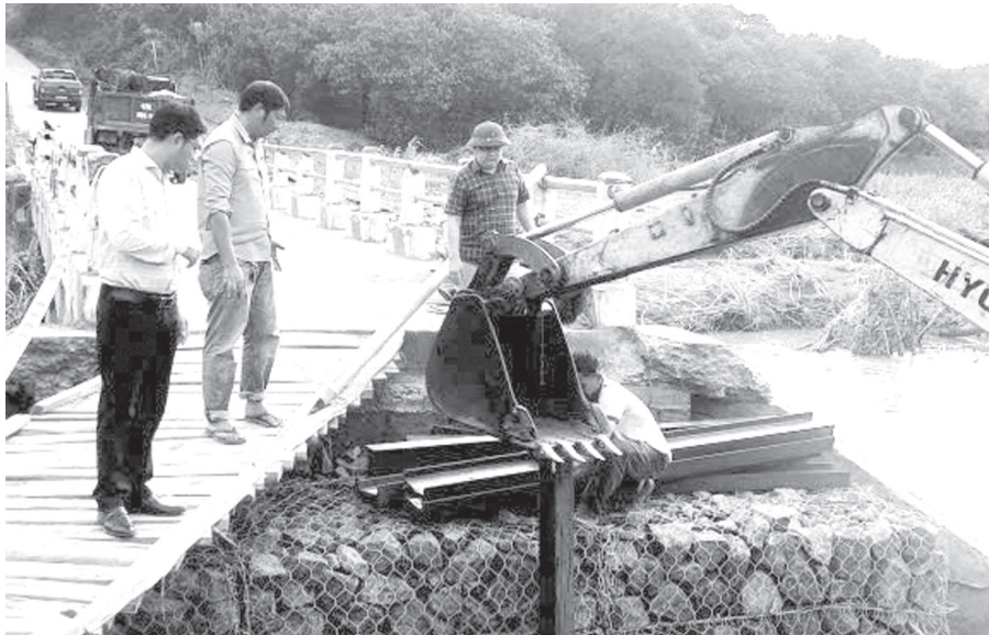
Chủ tịch UBND xã Ea Kiết Võ Sỹ Tùng kiểm tra công tác thi công sửa chữa cầu ở buôn H'Mông. Ảnh: V. Phê
