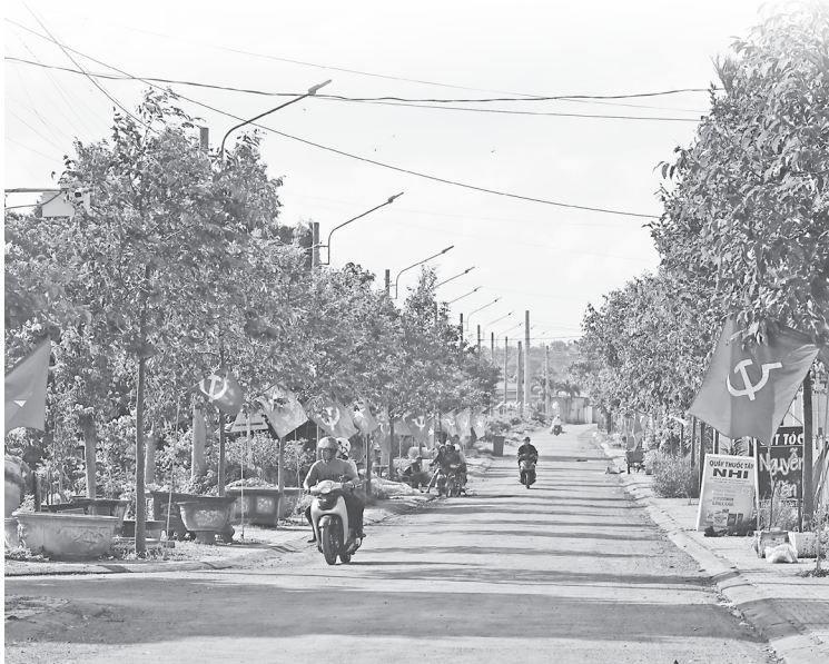
Hạ tầng giao thông trên địa bàn xã Ea Ning được quan tâm đầu tư. Ảnh: N. Hà
