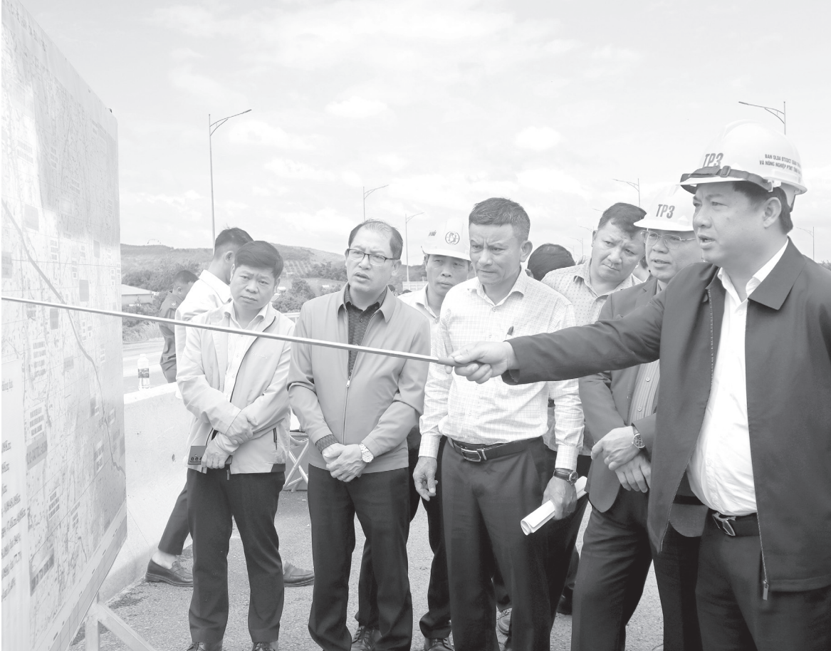
Bí thư Tỉnh ủy Lương Nguyễn Minh Triết cùng đoàn công tác kiểm tra tiến độ triển khai Dự án thành phần 3 thuộc Dự án cao tốc Khánh Hòa - Buôn Ma Thuột. Ảnh: H. Tuyết
