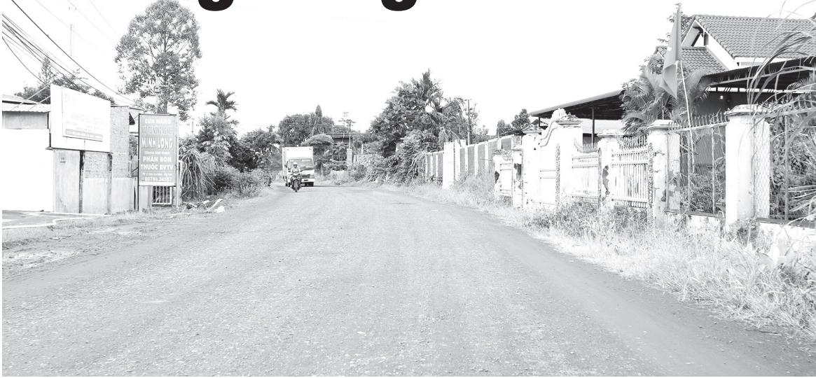
Tuyến đường liên xã Đắk Liêng - Đắk Phơi đang dần được hoàn thiện. Ảnh: Hoàng Hồng
