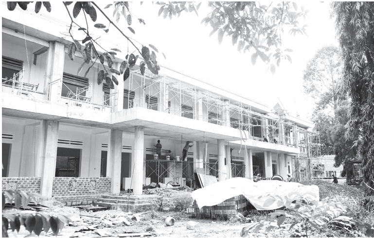
Các phòng học tại Trường Tiểu học Lê Thị Hồng Gấm đang được đẩy nhanh tiến độ thi công. Ảnh: Hoàng Hồng
