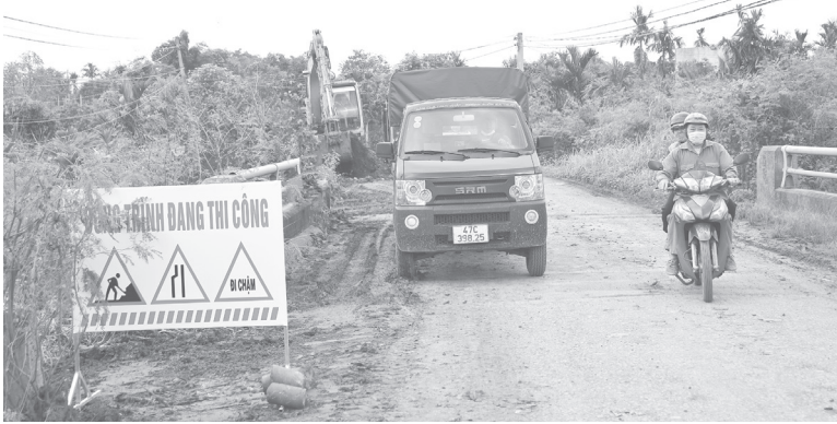
Một tuyến đường giao thông trên địa bàn xã đang được nâng cấp, sửa chữa. Ảnh: Hùng Hoàng
