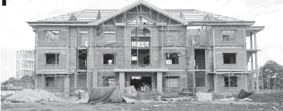
Trụ sở làm việc của HĐND và UBND xã với quy mô nhà 3 tầng đang khẩn trương xây dựng. Ảnh: Hùng Hoàng
