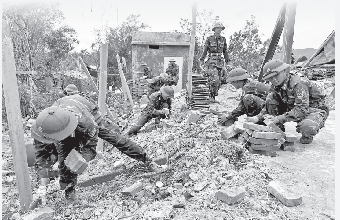
Các lực lượng vũ trang tham gia hỗ trợ người dân thu dọn những căn nhà sập hoàn toàn để sẵn sàng xây nhà mới theo chỉ đạo của Thủ tướng Chính phủ. Ảnh: Như Thanh
