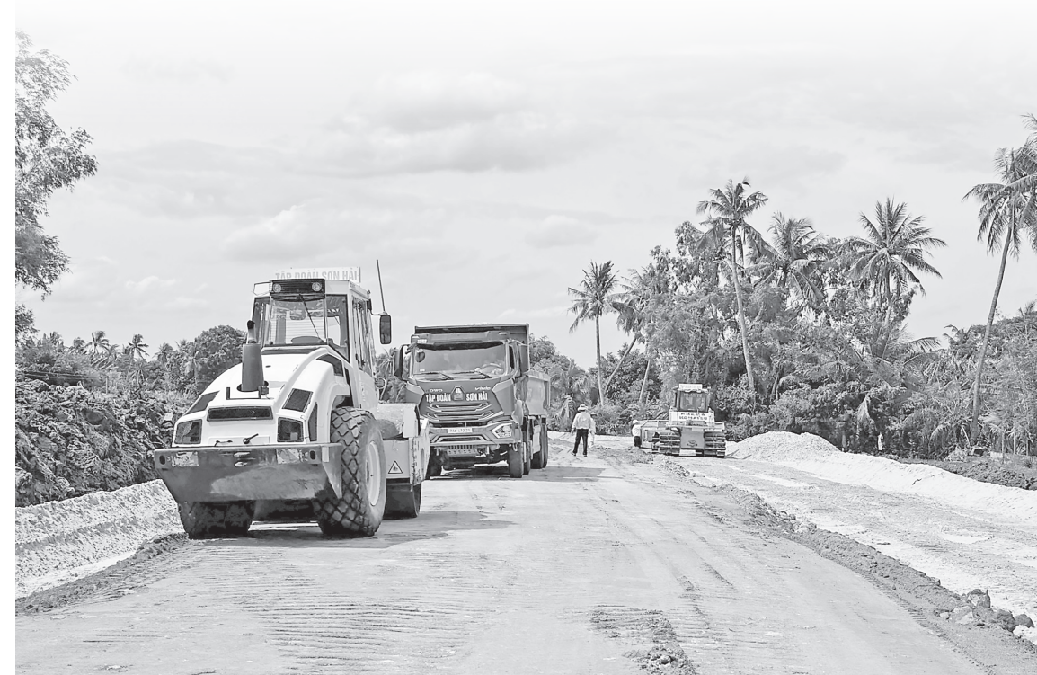
Nhà thầu công trình Tuyến đường bộ ven biển tỉnh vừa đẩy nhanh tiến độ thi công, vừa chờ mặt bằng sạch. Ảnh: N. Thanh
