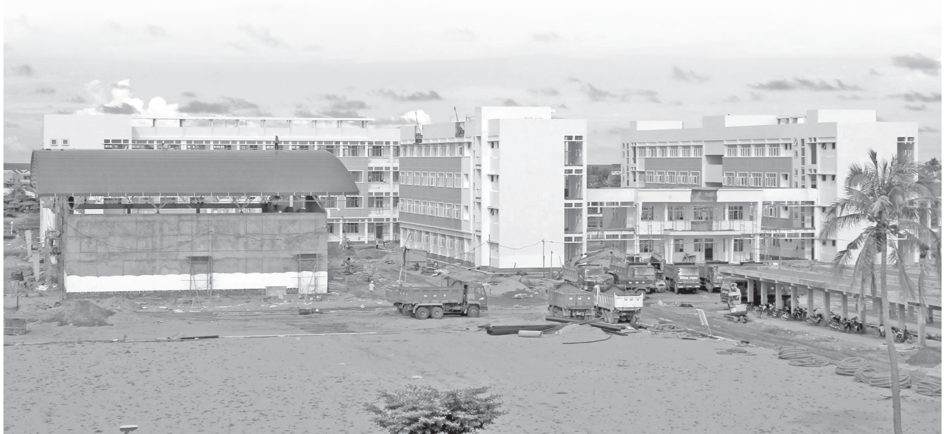
Ứng dụng công nghệ số trong thiết kế, quản lý giúp các dự án xây dựng được quản lý khoa học, hiệu quả. Ảnh: H. Như
