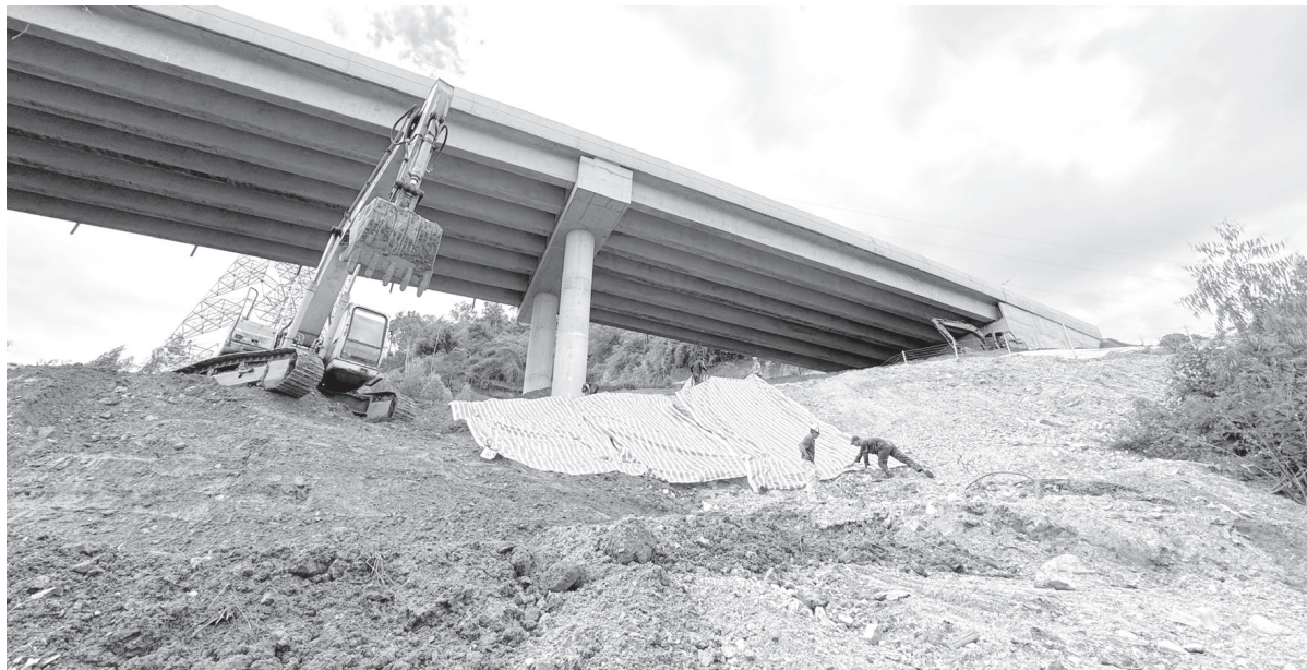
Nhà thầu tiến hành phủ bạt chống sạt trượt, hạn chế tối đa đất đá tràn vào nhà dân. Ảnh: N. Thanh
