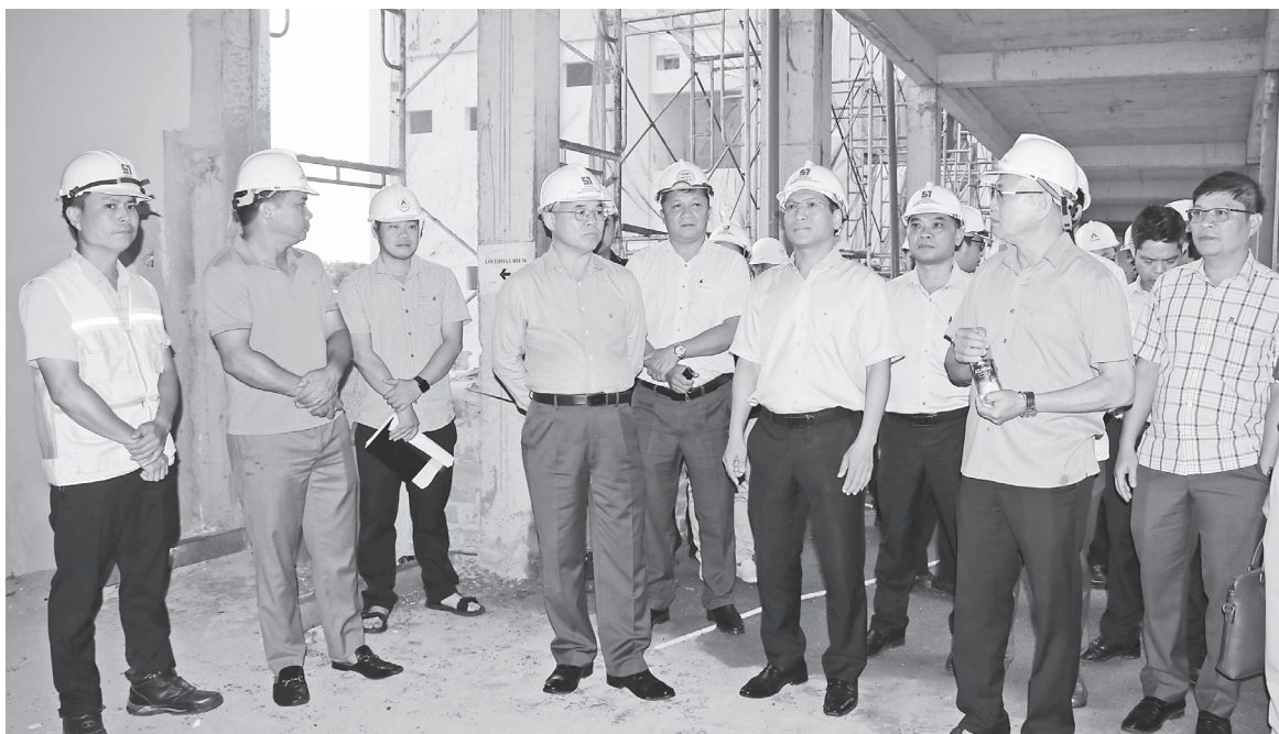
Phó Chủ tịch UBND tỉnh Trương Công Thái (thứ tư từ trái sang) yêu cầu chủ đầu tư và các nhà thầu đẩy nhanh tiến độ thi công Dự án Bệnh viện Đa khoa Buôn Hồ. Ảnh: T. Xuân
