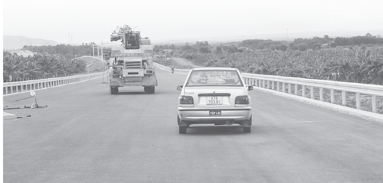
Phương tiện tập lái đi vào khu vực công trường đang thi công. Ảnh: H. Tuyết
