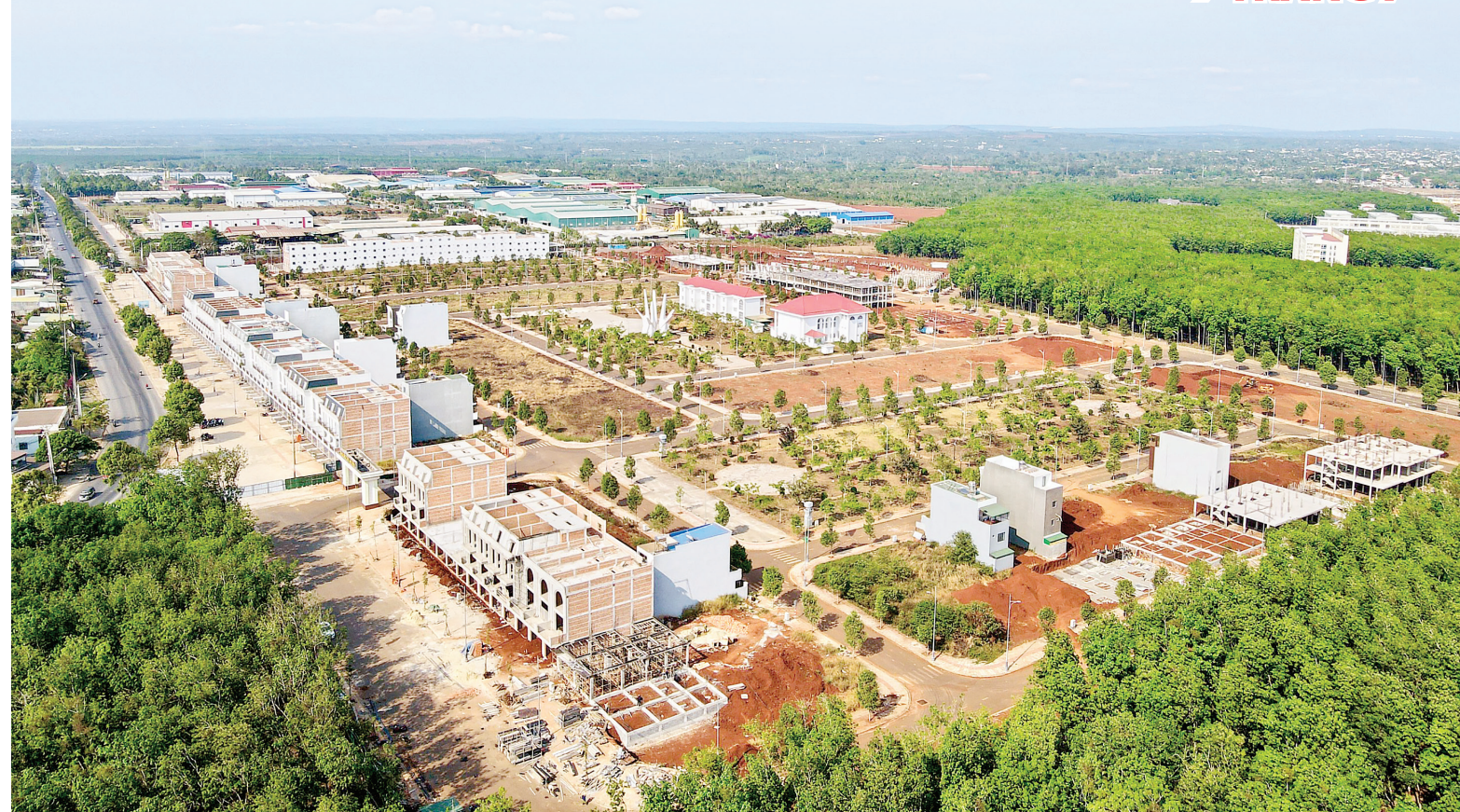
Một dự án khu đô thị đang triển khai trên địa bàn phường Buon Ma Thuột. Ảnh: Khả Lê
