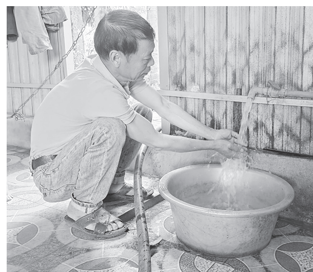
Người dân yên tâm khi sử dụng nguồn nước từ Công trình cấp nước tập trung xã Xuân Phú. Ảnh: A. Dũng
