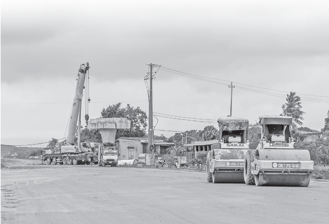
Cán đẩy nhanh tiến độ các công trình trọng điểm trên địa bàn tỉnh. (Trong ảnh: Thi công cao tốc Khánh Hòa - Buôn Ma Thuột). Ảnh: Nguyễn Gia
