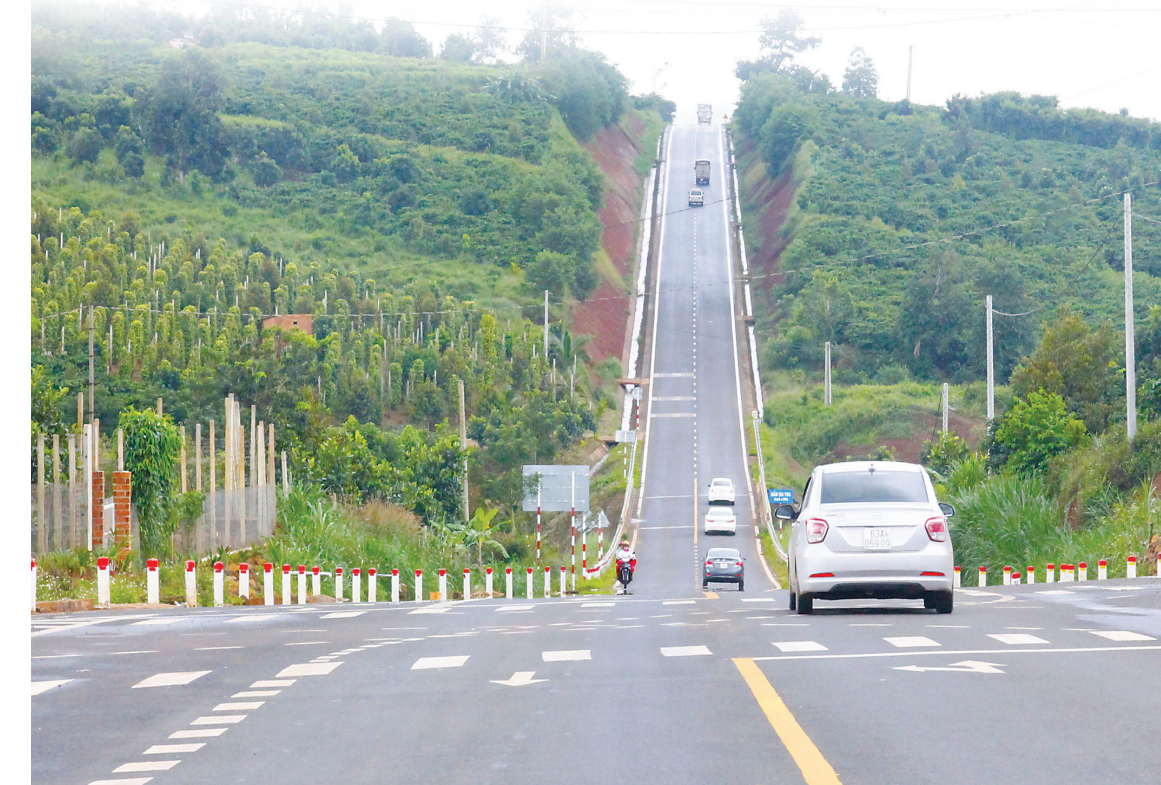
Đường Hồ Chí Minh đoạn tránh phía Tây thị xã Buôn Hồ được đầu tư không chỉ giảm tải cho trung tâm thị xã mà còn thuận lợi trong việc vận chuyển hàng hóa, nông sản. Ảnh: H. Tuyết
