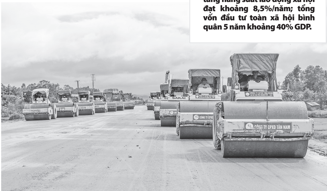
Các đơn vị thi công đang tăng tốc trên những công trình trọng điểm để hoàn thành tiến độ. Ảnh: Nguyễn Gia
